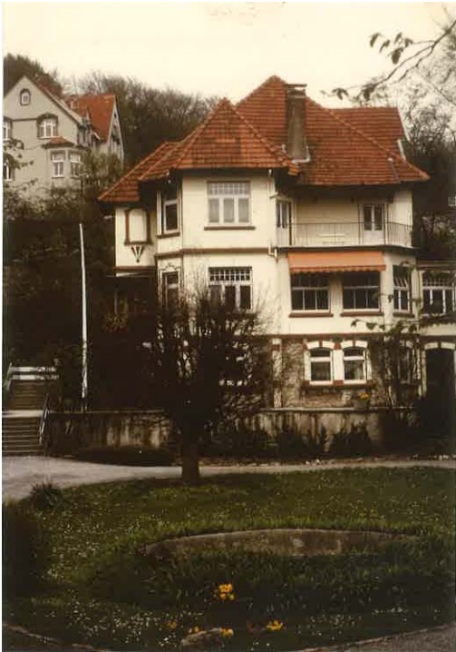
1983 war der Balkon mit Fenstern geschlossen
