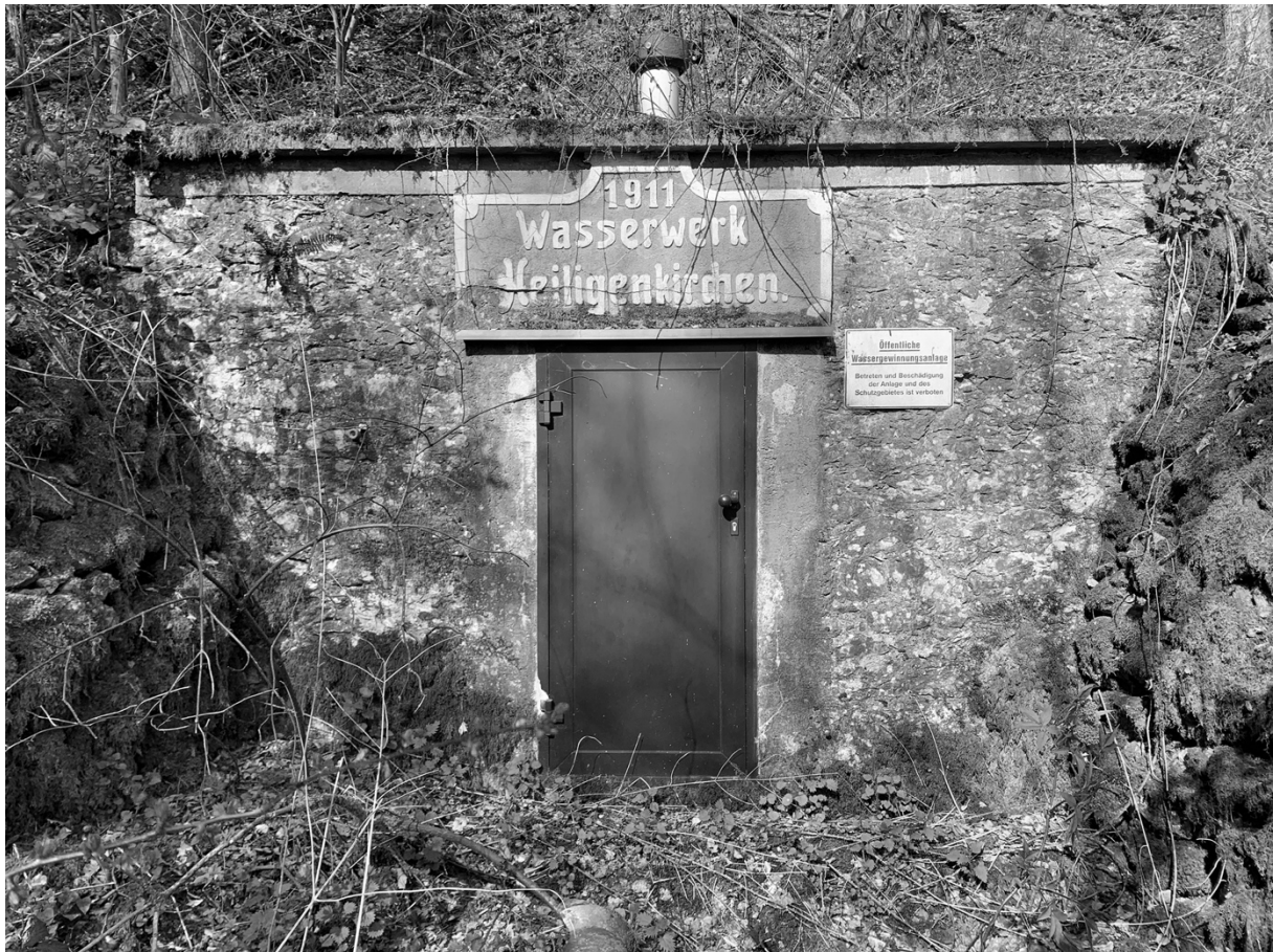
Hochbehälter des ersten Wasserwerks in Heiligenkirchen, erbaut 1911, Zustand 2021 (Foto: J. Kleinmanns)
