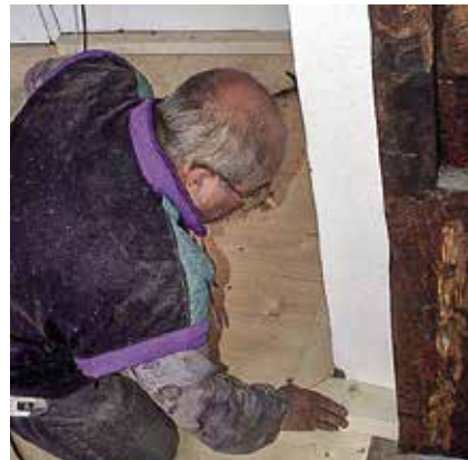
Das Anbringen der Fußbodenleisten erfordert viel Ausgleichsvermögen
