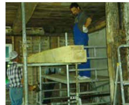
Wilhelm Möllenbrok und Burkhard Missal bringen den Deckenbalken in Position
