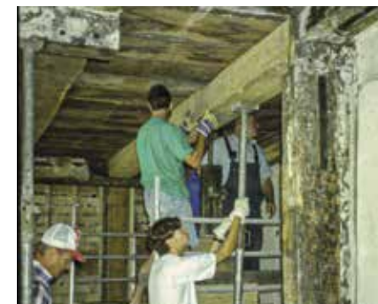
Der schwere Balken ist in der richtigen Position – er liegt an beiden Seiten richtig auf
