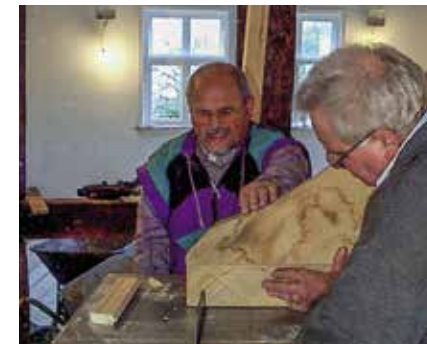
Fehlende Kopfänder müssen neu eingepasst werden
