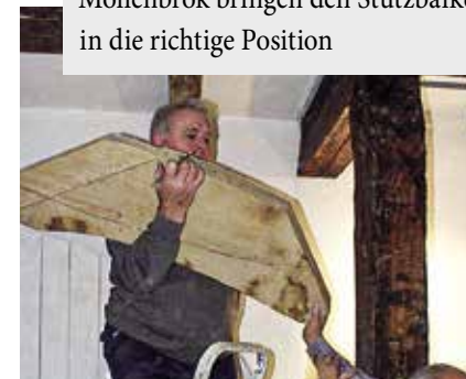
Ein Kopfband wird wieder unter die Decke gebracht
