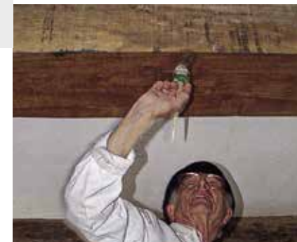
Walter Krüger bringt Farbe auf den neuen Deckenbalken, damit er farbähnlich zu den alten Balken wird
