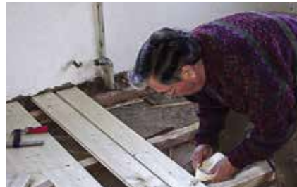
Manfred Blaschko verlegt die neuen Fußbodendielen ...
