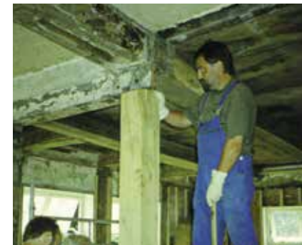
Der Balken steht
