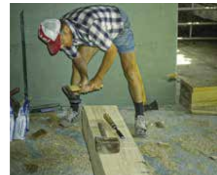
Nach dem Zuschnitt im Sägewerk bearbeitet Wilhelm Möllenbrok den Deckenbalken mit dem Beil
