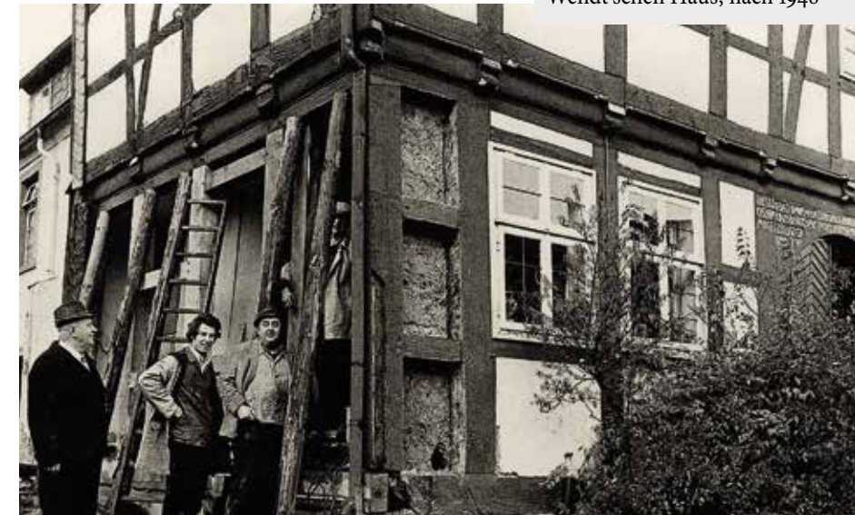
Bürgermeister Fritz Schäperkötter prüft die Reparaturarbeiten am Wendt'schen Haus, nach 1948
