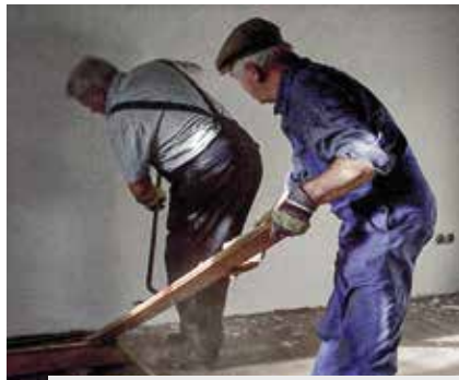
Gerd Engstfeld und Heinrich Rosenstock entfernen die alten Fußbodendielen
