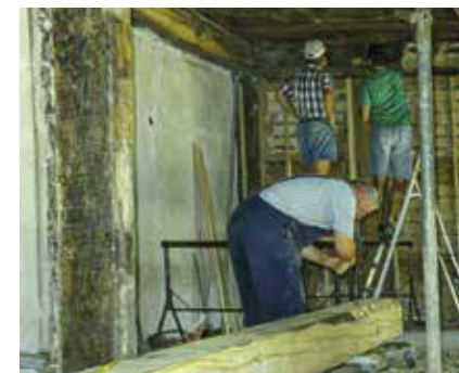
Der Balken muss unter die Decke – alles wird vorbereitet
