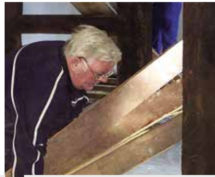
„Seppel“ Brünig entsorgt die Fußbodendielen
