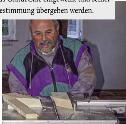
Horst Mönning schneidet die extra breiten Fußbodenleisten zu
