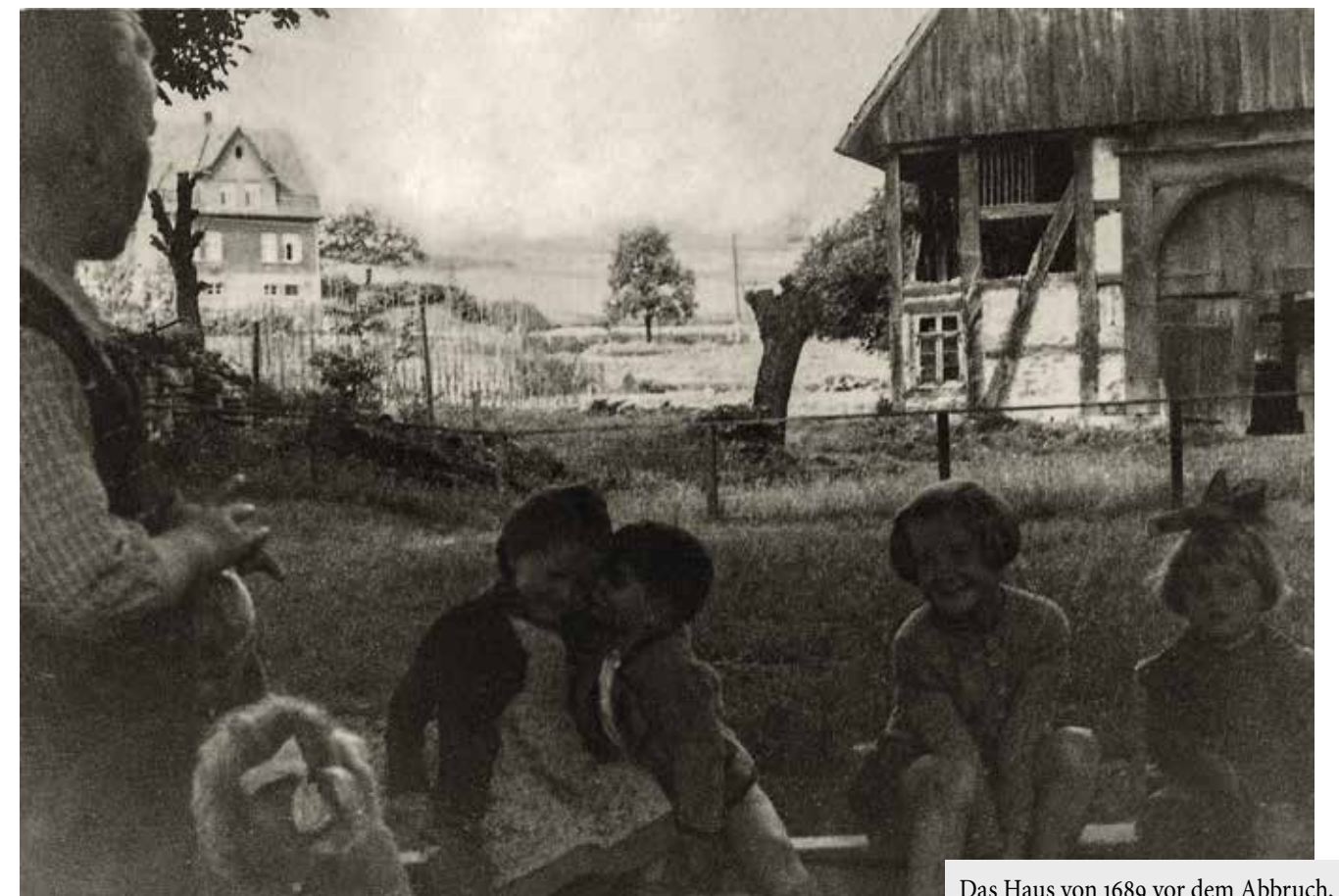
Das Haus von 1689 vor dem Abbruch, um 1930
