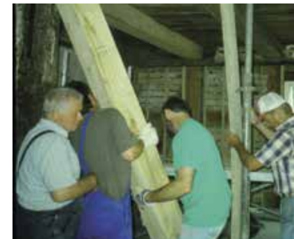
Auch die marode Stütze wird erneuert. Gerhard Engstfeld, Uli Asmus, Burkhard Missal und Wilhelm Möllenbrok bringen den Stützbalken in die richtige Position
