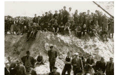
Bau des Sporthäuschens mit Duschanlagen
