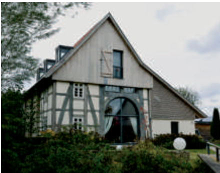
A170 · Denkmalstraße 33 Dreiständerfachwerk von 1724 (Nähe Fleischerei Kruel)
