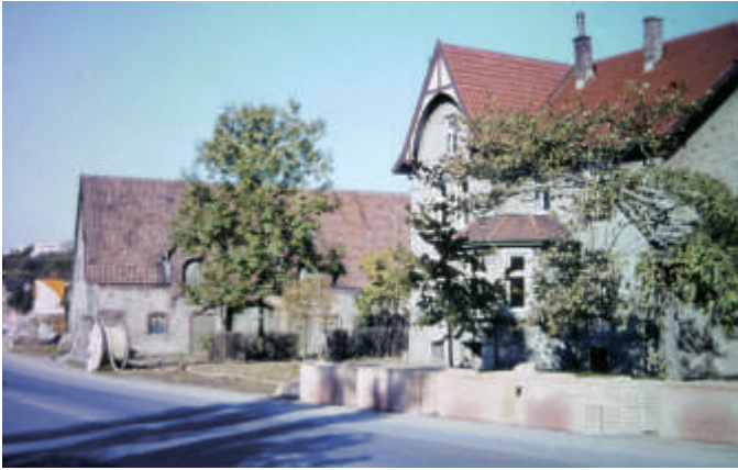
Der »Waterhof« an der Paderborner Straße vor dem Abriss 1964
