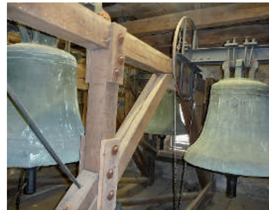
Das Turmdach mit den Glocken
