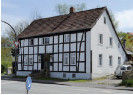
A173 · Denkmalstraße 2 Kreuzung Paderborner Straße Fachwerkhaus · keine Daten vorhanden
